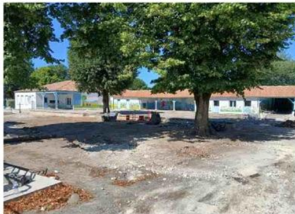
La cour de l'école a été débarrassée de sa couche de béton. S'ensuivront la végétalisation et les aménagements avant la rentrée. P. M.
