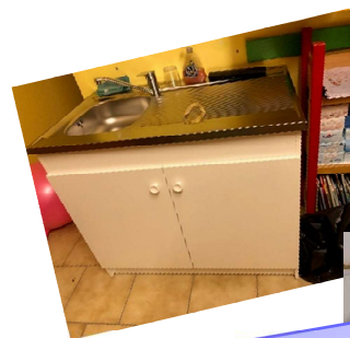
Ecole Maternelle : mis en place d'un évier et de deux WC Local jeune : installation d'un évier
